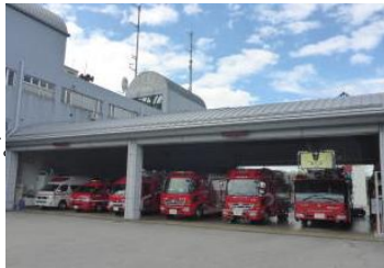
吉川消防署車庫前の写真
